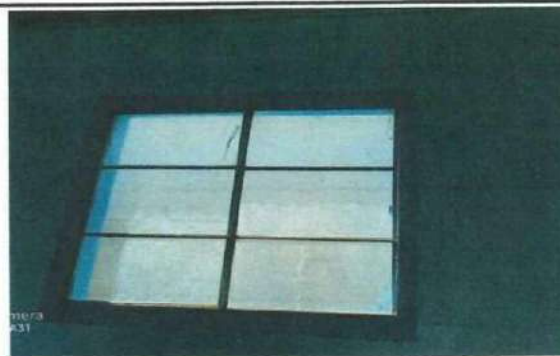
Foto 4: cambio de venta, vidrios y colocación de balcon parte atrás del aula 4 y 5
