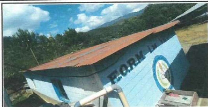
Foto1: cambio de lamina a lamina alucin y colocación de 3 hilada de block
