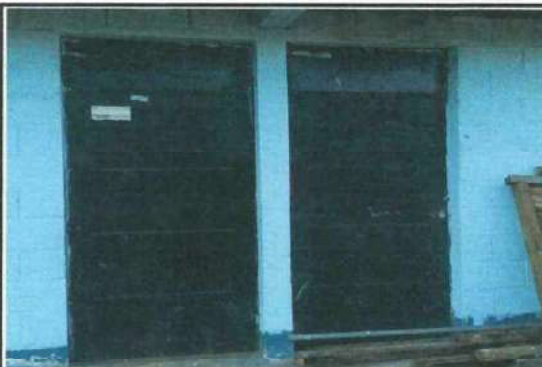
Foto 10: cambio de las 2 puertas del aula 4 y 5
