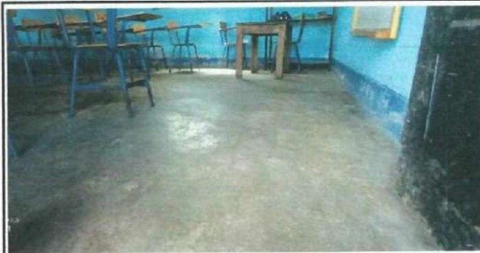
Foto 2: colocacion de piso cerámico en el aula 4 y 5
