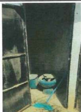
Foto 5: cambio de inodoro y remodelación de baños
