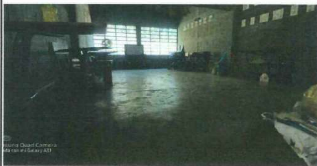
Foto 7: colocación de piso ceramico del aula 1
