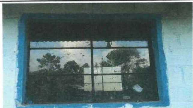
Foto 3: cambio de ventana, vidrios y colocación de balcón, parte de enfrente del aula 4 y 5
